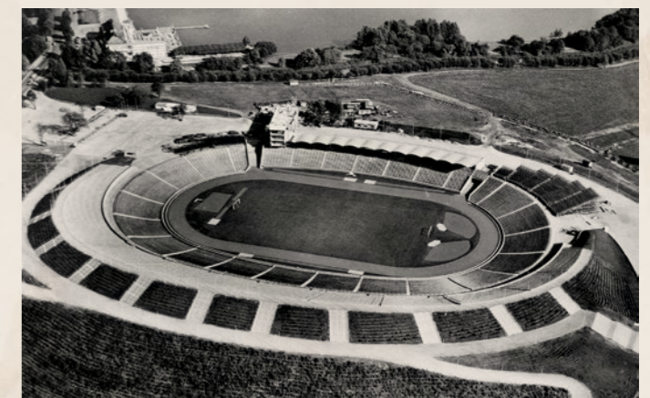
NIEDERSACHSENSTADION, UM 1954 NOCH OHNE ÜBERDACHUNG, ANZEIGETADEL UND FLUTLICHTMASTEN
